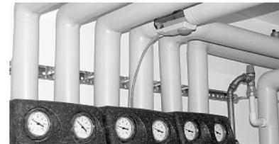
**Bild 1.7:** Gedämmte Rohrleitungen.
