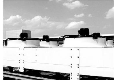
**Bild 1.1:** Rückkühlwerk einer Klimaanlage.
