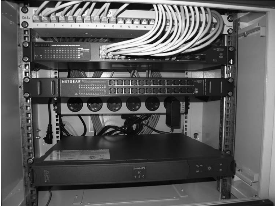
BILD 1.1 19"-Netzwerkschrank mit USV
