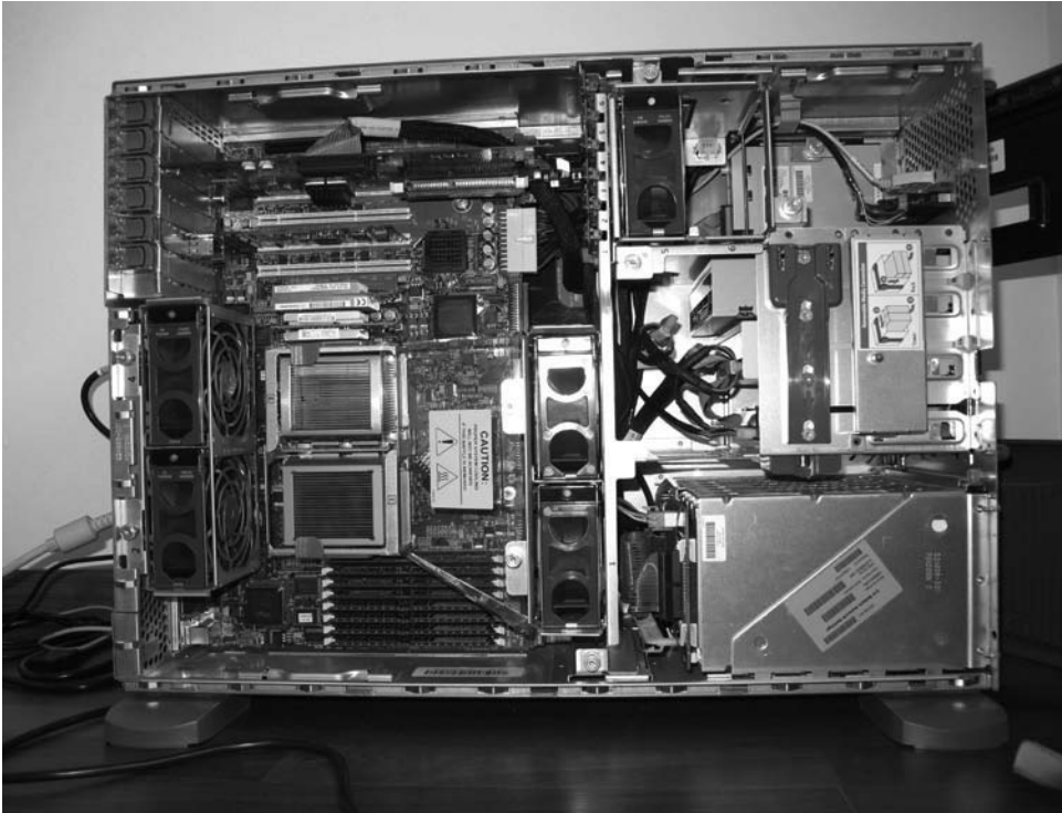
BILD 1.2 Server (HP-Proliant) während des Lüftertauschs
