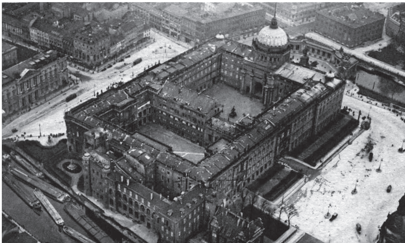
Eine frühe Luftaufnahme des Berliner Schlosses um 1900. Gut kann man sehen, dass das Gebäude keine organische Struktur besitzt, sondern aus unterschiedlichen Fragmenten besteht, die sich im Lauf der Zeit anlagerten. Als letzter, großer Bauteil wurde dem Westportal (oberer Bildrand) 1853 die Kuppel von Friedrich August Stüler aufgesetzt.
