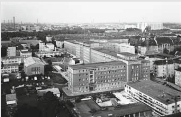
Blick über das Stadtgebiet um 1975, im Vordergrund die MFS-Zentrale, rechts dahinter die neogotische Glaubenskirche und das Gebäude des Stadtbezirksgerichtes Lichtenberg, in dem Regimekritiker abgeurteilt wurden
