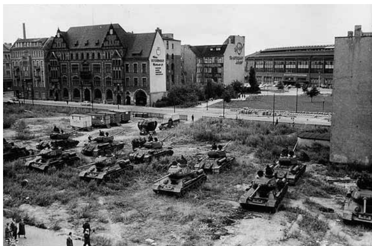
13. August 1961: Kampfgruppen und Wasserwerfer beziehen Stellung am Brandenburger Tor; am Bahnhof Friedrichstraße stehen Panzer in Bereitschaft
