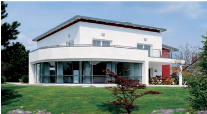
Abb 1.3: Verschiedene Haustypen mit kompaktem Baukörper, zum Teil mit Anbauten. (Fotos: WeberHaus)
