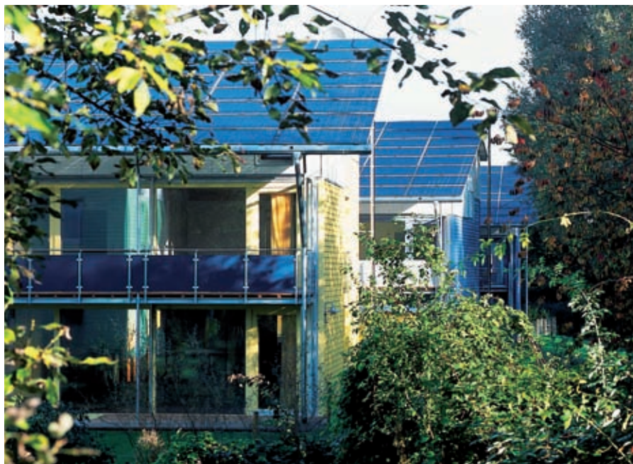
Abb 1.2: Plusenergie®-Penthäuser: Sie brauchen nach Angaben des Anbieters je nach Größe zwischen 1.650 und 1.800 Euro weniger an Heizkosten als ein vergleichbarer Neubau in konventioneller Bauweise. Gleichzeitig soll der von der Solaranlage gewonnene Strom für jährliche Einnahmen von etwa 4.500 Euro sorgen. (Foto: Architekturbüro Rolf Disch)
