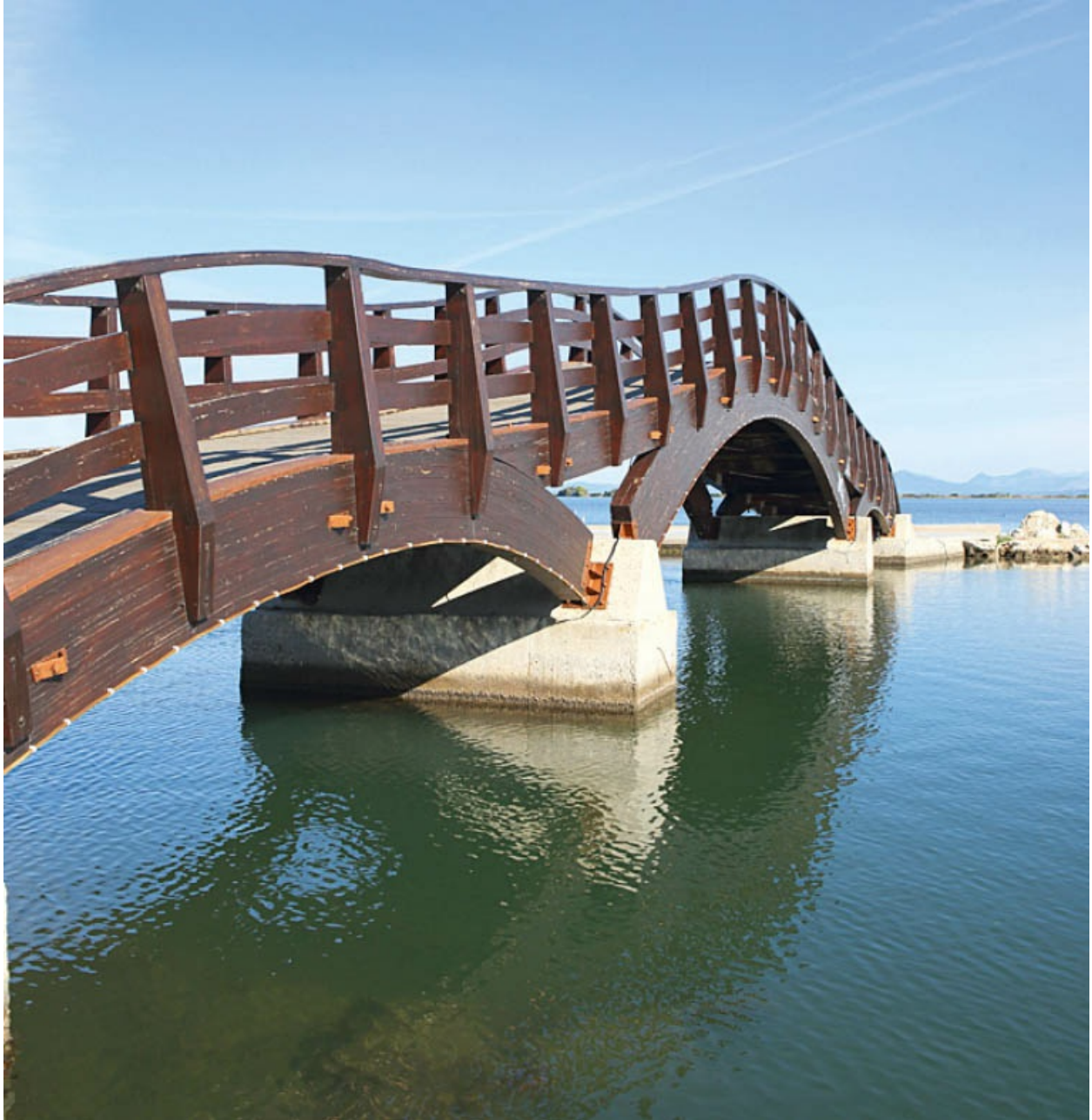
Alte Fußgängerbrücke in Lefkáda-Stadt
