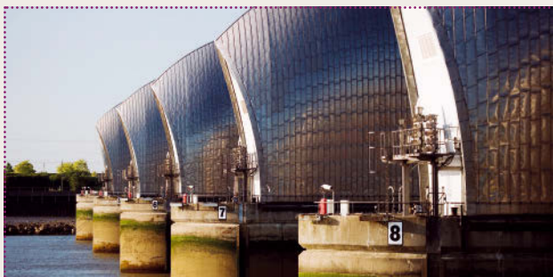
Thames Barrier – größte bewegliche Sturmflutbarriere weltweit
