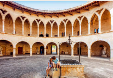
Der Innenhof des um 1309 oberhalb der Bucht von Palma errichteten Castell de Bellver wird von einer doppelten Bogengalerie eingefasst.
