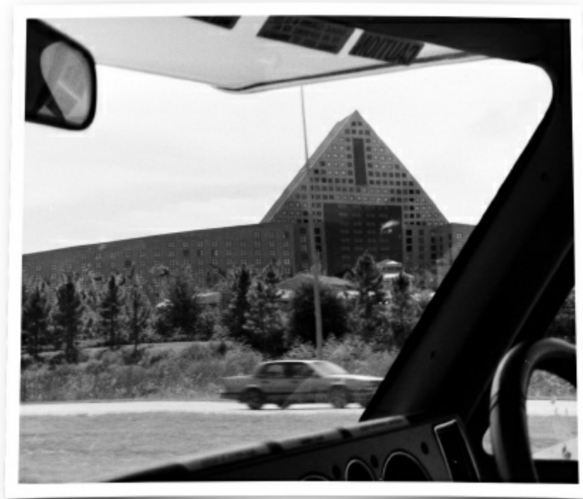
Zentrale des Bayerischen Rundfunks in München-Freimann, circa 1994. Da heute viele Aufgaben des BR digital bewältigt werden können, wurde der Westflügel (l.) Anfang der 10er-Jahre kontrolliert niedergebrannt.
