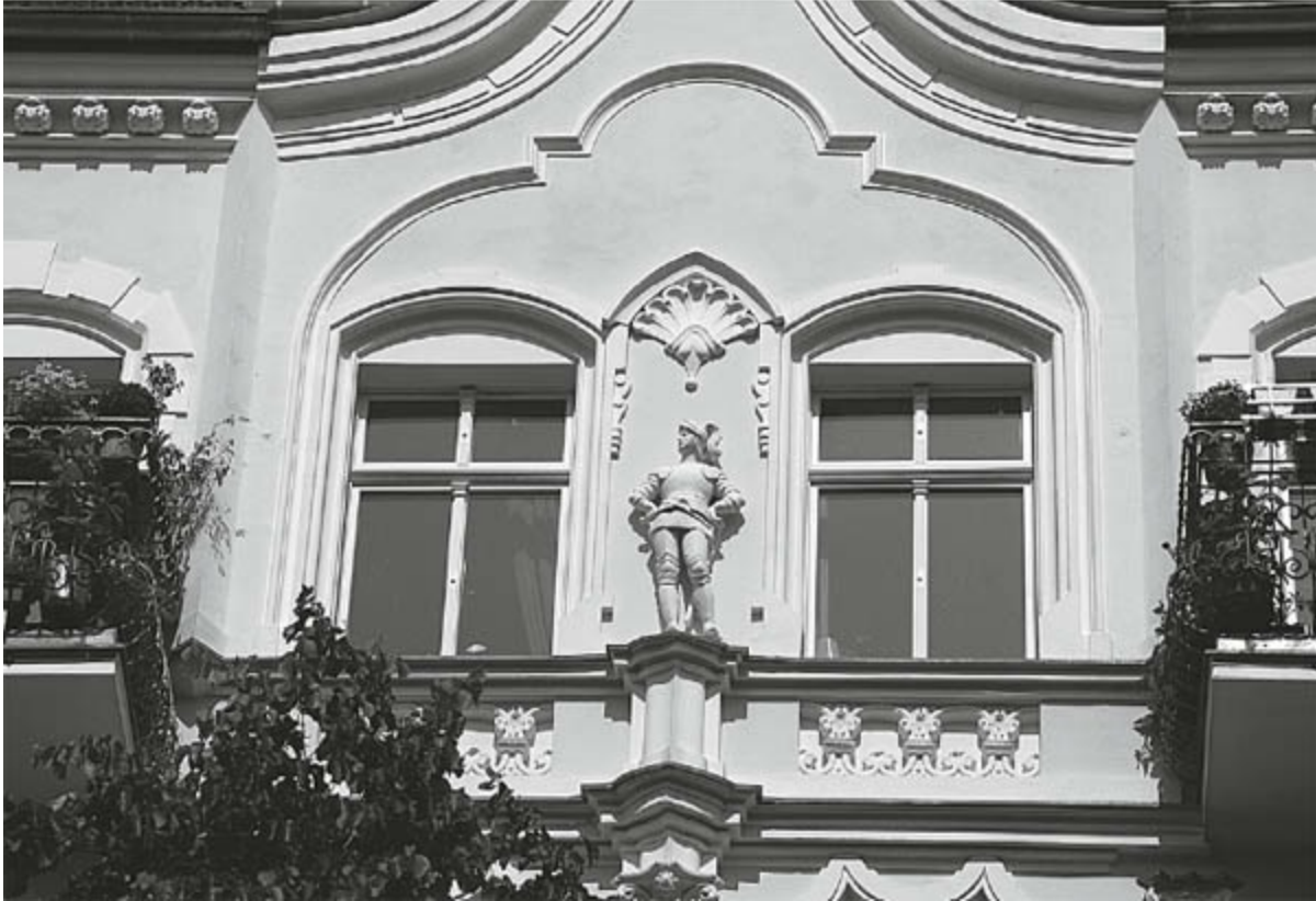
Der sanierte »Ritter« an der Fassade Winsstraße 61
