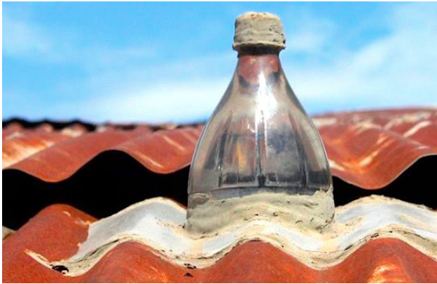
Abbildung 2: Die Funktionsweise der Liter Licht Lampe (Bild mit freundlicher Genehmigung von LitrodeLuzColombia)
