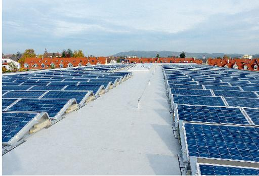
**Aufgeständerte und ballastierte Modulreihen**
