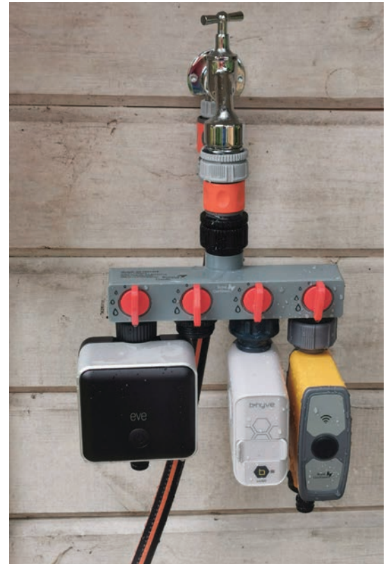
Ein Vierfachverteiler unter dem Wasserhahn ermöglicht es, unterschiedliche Zonen zu bewässern.
