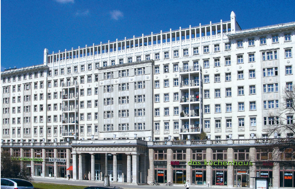
Karl-Marx-Allee (vormals Stalin-allee) Nord, Block C, heutiger Zustand nach Rekonstruktion
