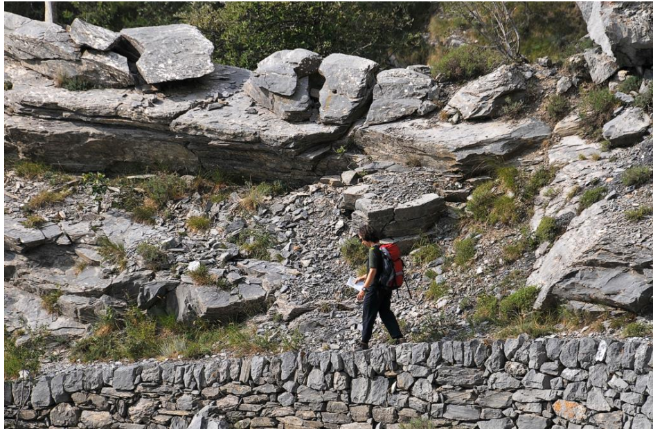
Gemauerte Pfade: Wegbefestigung in den ligurischen Alpen (Tour 3)
