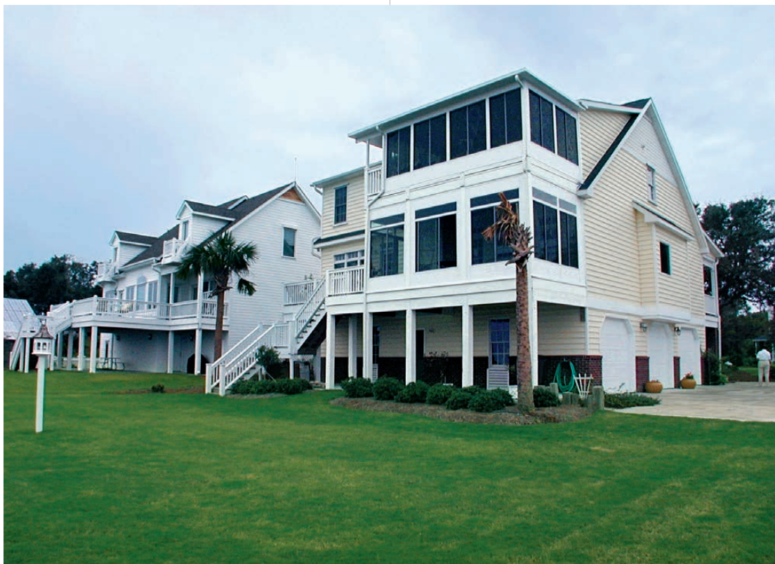
▲ 3.29: Neubau eines Wohnhauses in einem durch Hochwasser gefährdeten Gebiet in den USA. Der Wohnbereich und die Technik des Hauses wurden in die höheren Stockwerke und unter das Dach gelegt, außerdem wurden die Fundamente und weitere Teile des Hauses speziell in Hinblick auf ein Hochwasser verstärkt.
