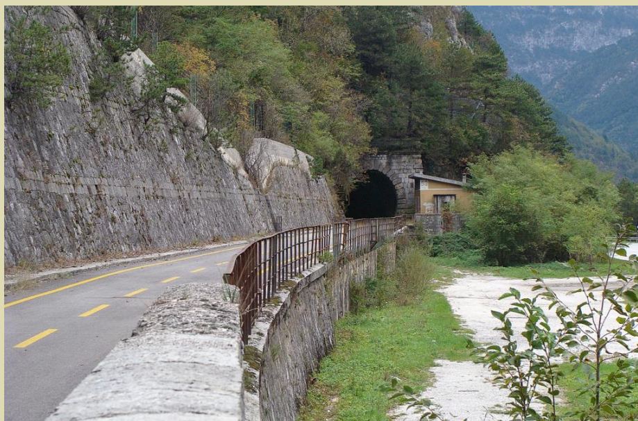
Neuer Radweg auf der alten Bahntrasse
