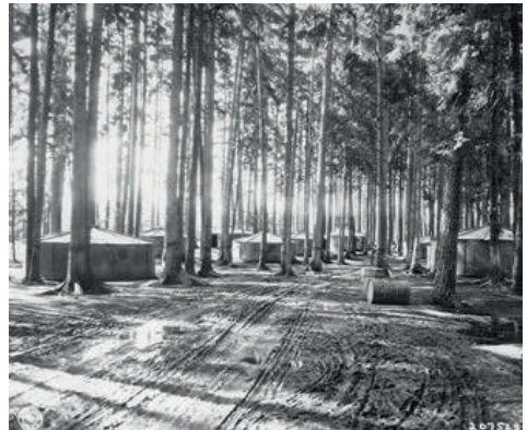
Das Außen-lager Ampfing vom Mühldorf-Komplex. Das Foto ist vom 7. Mai 1945.
