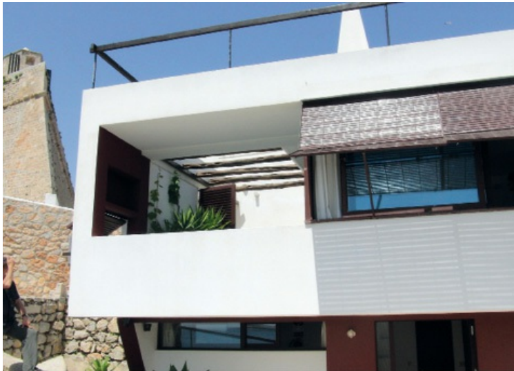
Wohnhaus des Architekten Erwin Broner
