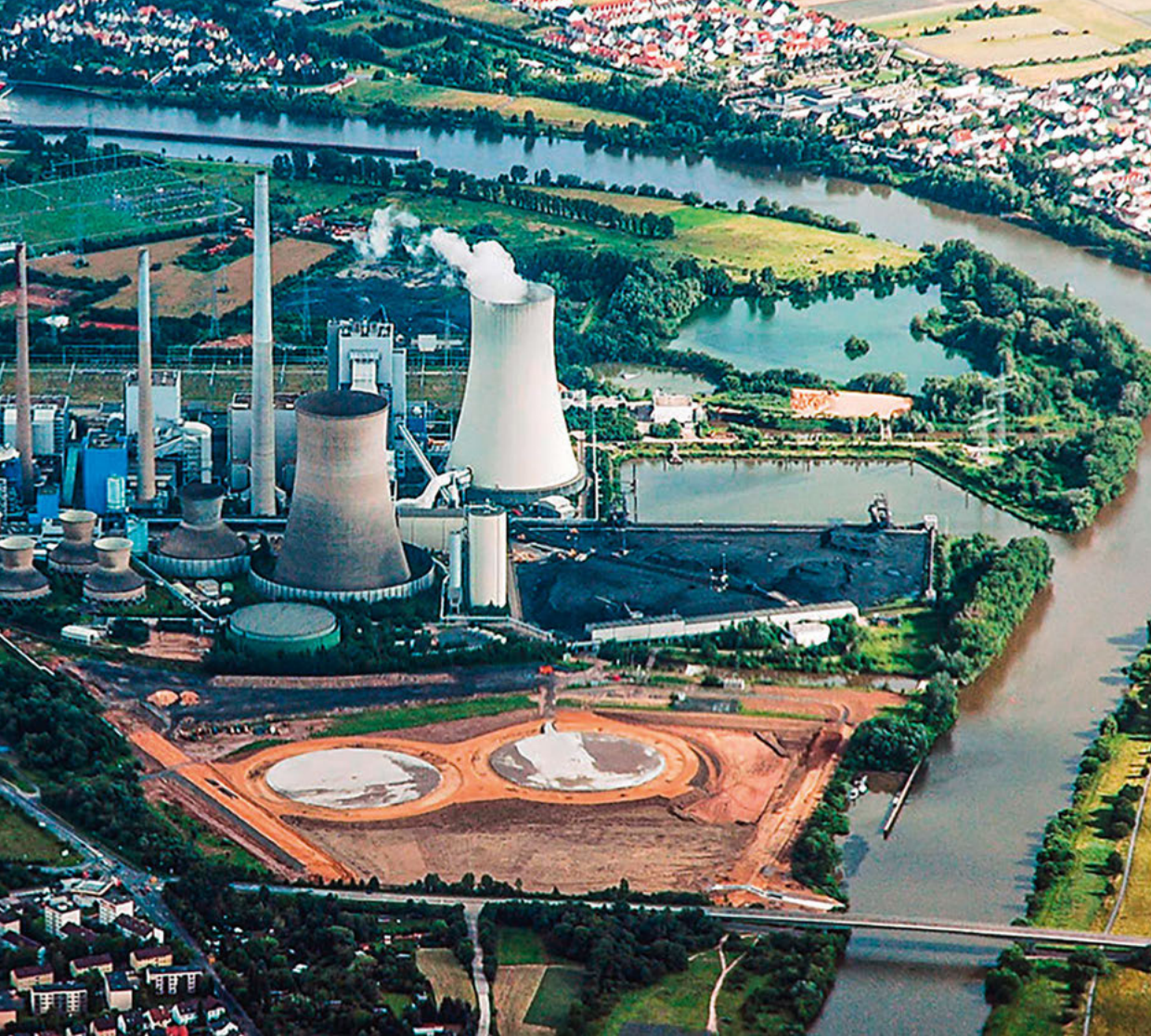
Abbildung 124: Kohlekraftwerk Großkrotzenburg, Hessen, Deutschland.
