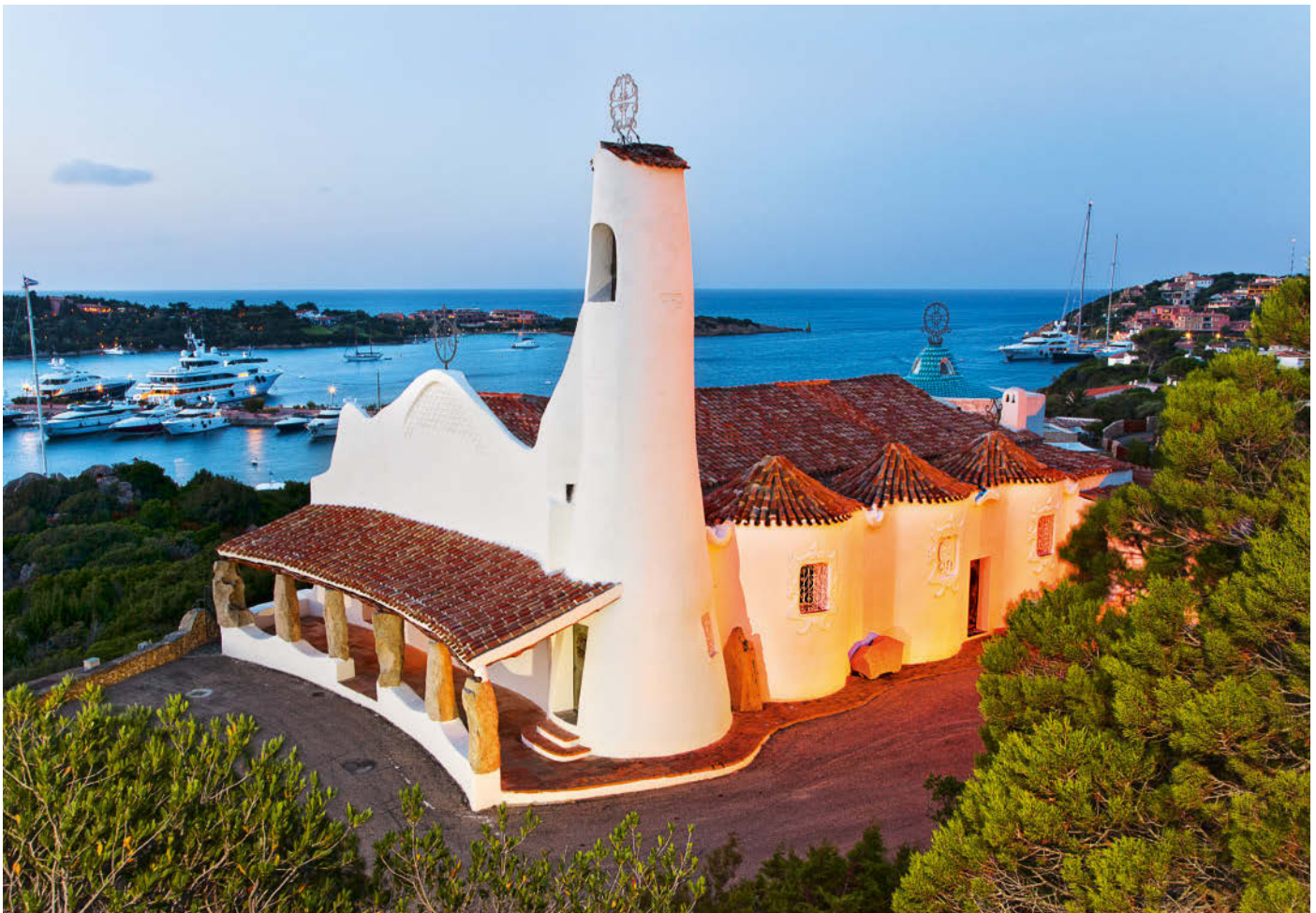
Oberhalb des Jachthafens von Porto Cervo steht die Kirche Stella Maris („Stern des Meeres“). Zu den typisch sardischen Elementen ihrer Architektur gehören die das Dach der Vorhalle tragenden, an Menhire erinnernden Granit-Monolithen.
