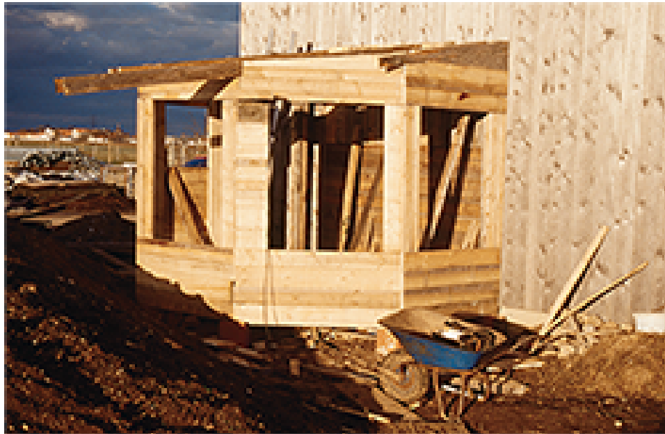
Der Rohbau mit der ersten, waagerechten Lage Bretter mit ausgesparten Fenster- und Türöffnungen. Auf die erste kommt eine zweite, diagonale Lage Bretter.
