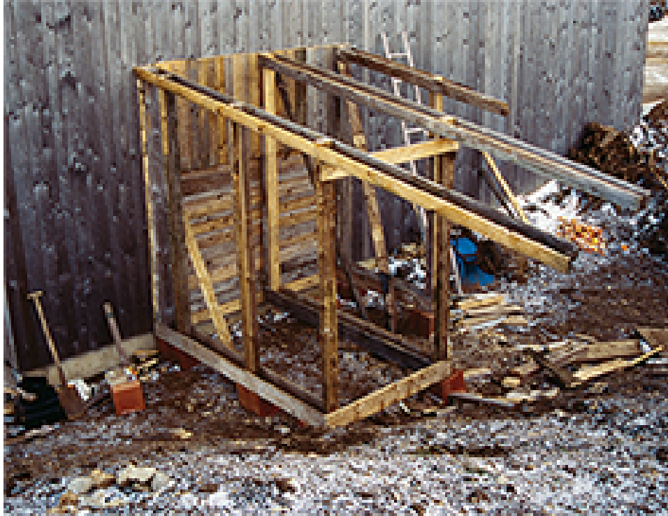
Sieben Hohlblockziegel bilden das Fundament, auf dem die senkrechten Pfosten des Häuschens stehen. Diese sind durch Doppelpfetten und einzelne Bretter miteinander verbunden.
